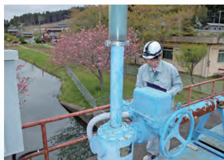
土地改良施設の診断
